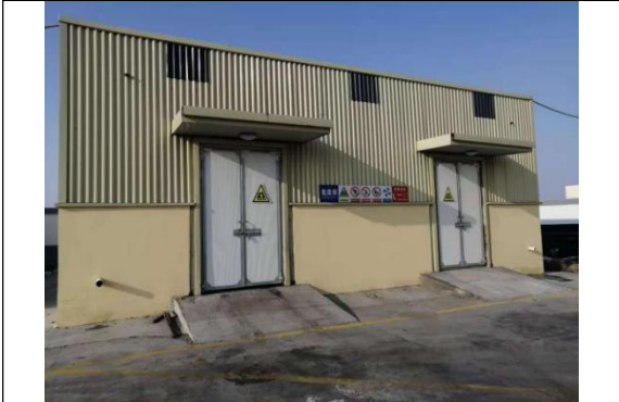
工业场地危废暂存库
