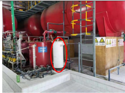
硫酸、盐酸储罐酸雾捕集器
