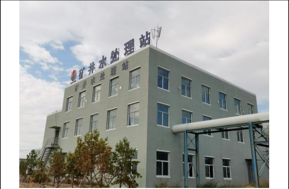
矿井水预处理站
