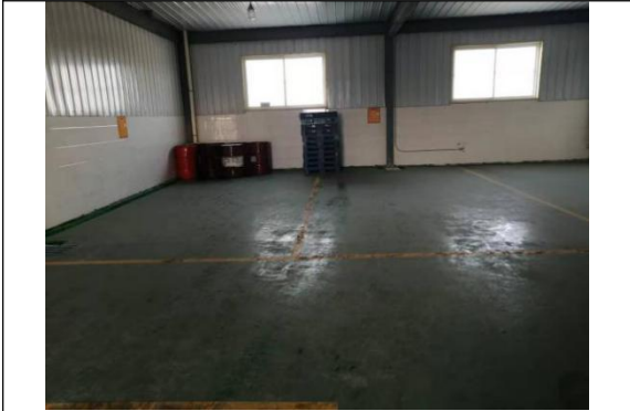
危废暂存库地面防腐涂层
