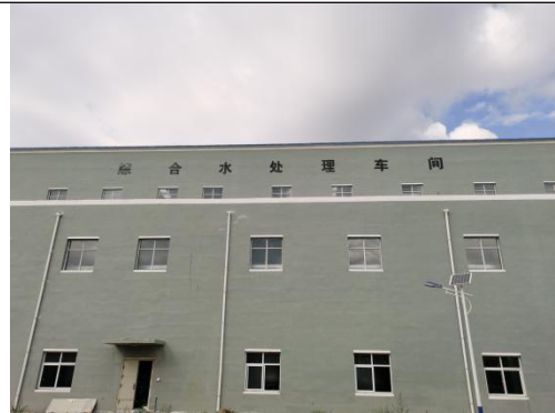
综合水处理车间
