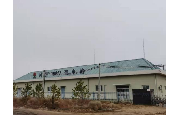
风井场地 110kV 变电站
