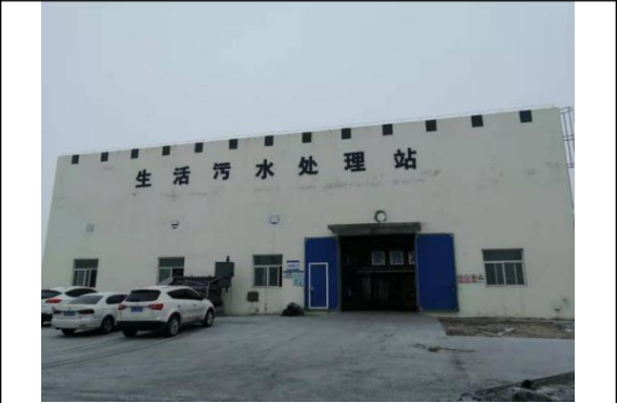
工业场地生活污水处理站
